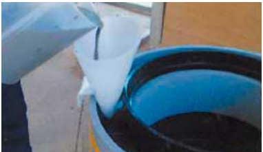
④铸铁枠に設けられたボルト孔よりグラウト材を流し込みます。
