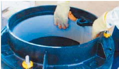
②鋳鉄枠内側を内フォームを用いて閉塞します。
