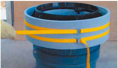
③鋳鉄枠外周部を外フォームを用いて閉塞します。
