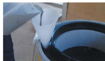
⑤鋳鉄枠に設けられたボルト孔よりグラウト材を流し込みます。
