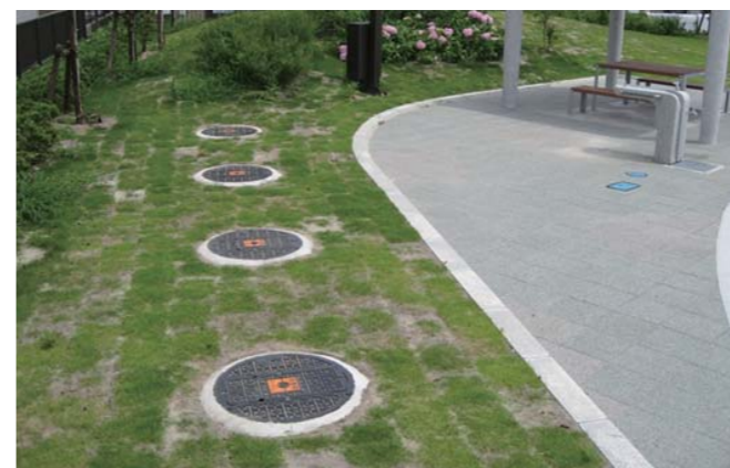
現場名：美田園風の音公園 設置場所：名取市
