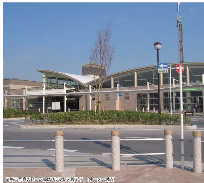
※施工写真のビーム部はステンレス製です。(オーダー対応)
