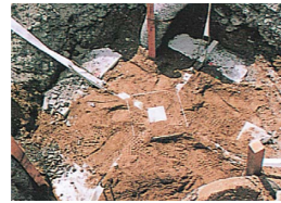
セットしたベルトを植穴から出す
