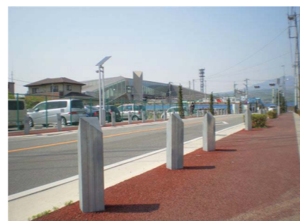
場 所：山梨県甲斐市竜王駅 施工年度：2007年（平成19年） 設置製品：HCS-900N-18 仕 様：亜鉛メッキ仕上、反射板付
