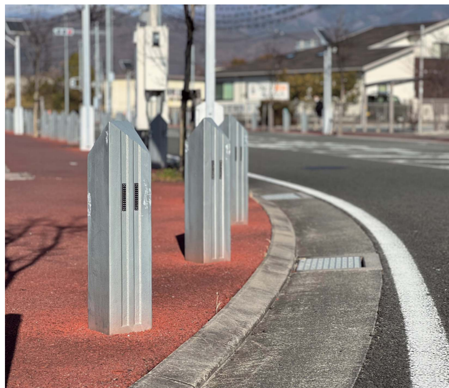
場 所：山梨県甲斐市竜王駅 施工年度：2007年（平成19年） 設置製品：HCS-900N-18 仕 様：亜鉛メッキ仕上、反射板付
